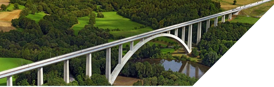
Talbrücke Froschgrundsee (Foto: Nürnberg Luftbild, Hajo Dietz)
