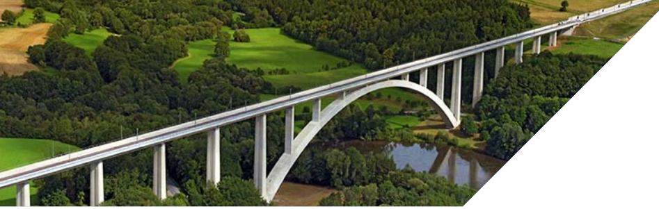
Talbrücke Froschgrundsee (Foto: Nürnberg Luftbild, Hajo Dietz)
