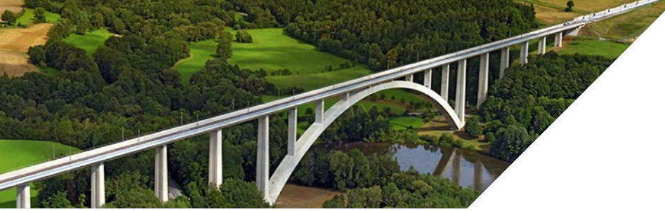
Talbrücke Froschgrundsee (Foto: Nürnberg Luftbild, Hajo Dietz)
