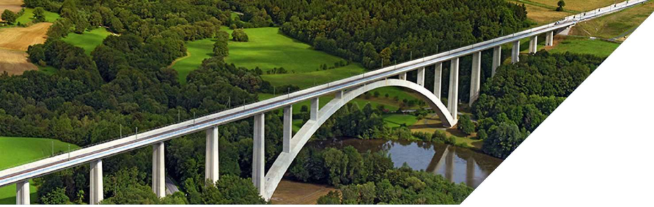
Talbrücke Froschgrundsee (Foto: Nürnberg Luftbild, Hajo Dietz)
