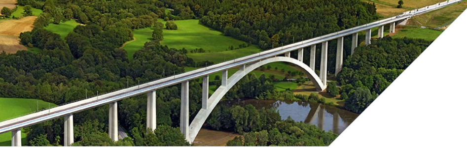
Talbrücke Froschgrundsee (Foto: Nürnberg Luftbild, Hajo Dietz)
